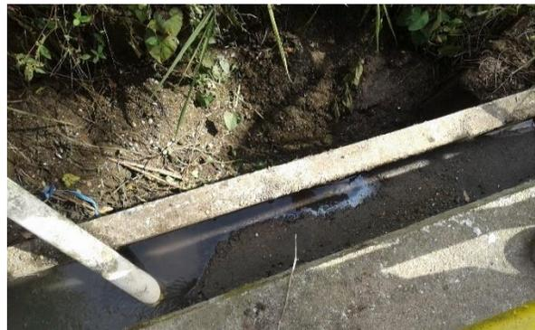
Fotos C.G.Q. Nos. 16 - 17: Estructura de entrada a la PTAR del Municipio de Buenavista – Faltan rejillas o barreras de cribado.
