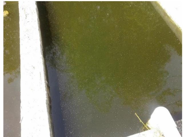
Fotos C.G.Q. Nos. 18 - 21: Estructura de almacenamiento de lodos inundada.
