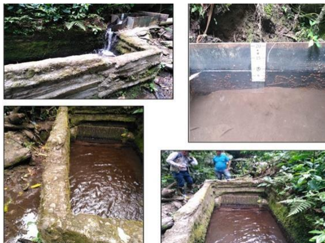
Imagen 5: Bocatoma Bolivia. Fuente: Propia
