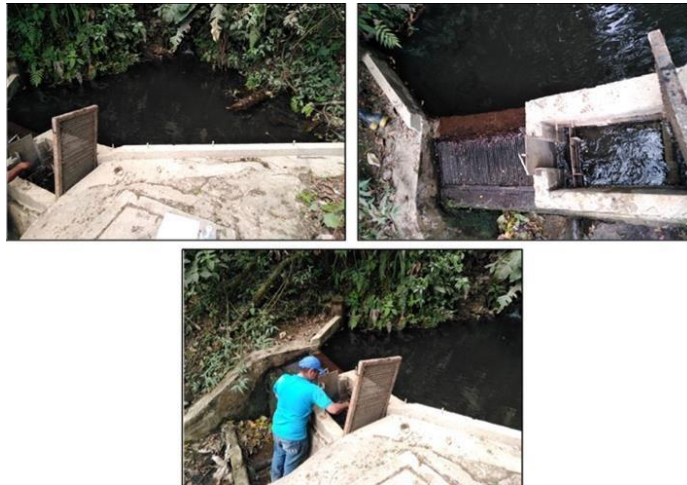
Imagen 4: Bocatoma Corozal. Fuente: Propia
