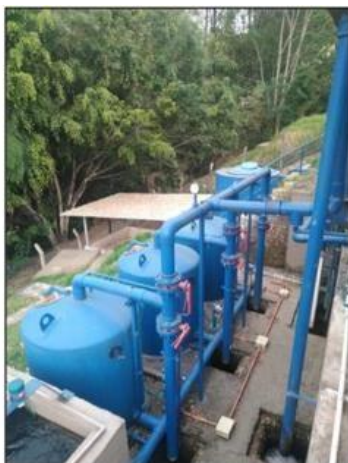
Imagen 9: Filtros y unidades de secado. Fuente: Propia
