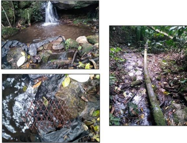
Imagen 6: Bocatoma La Cristalina. Fuente: Propia
