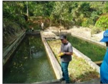
Imagen 4: Desarenador. Fuente: Propia
