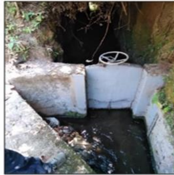
Imagen 10: Cámara de Llegada Concesión EPA. Fuente: Propia
