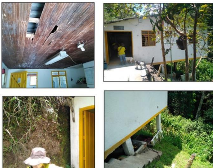
Imagen 13: Estación de Bombeo 2 Las Águilas. Fuente: Propia
