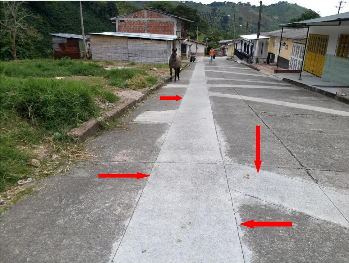
Fotografía No 01: Juntas de dilatación pavimento rígido sin sellar
